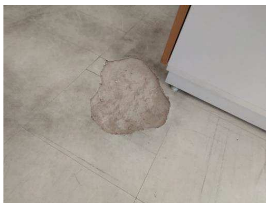
Figuras 17 e 18: Imagens de alguns dos danos existentes no piso
