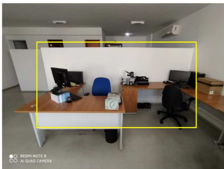
Figura 13: Imagem da parede de drywall a ser retirada
